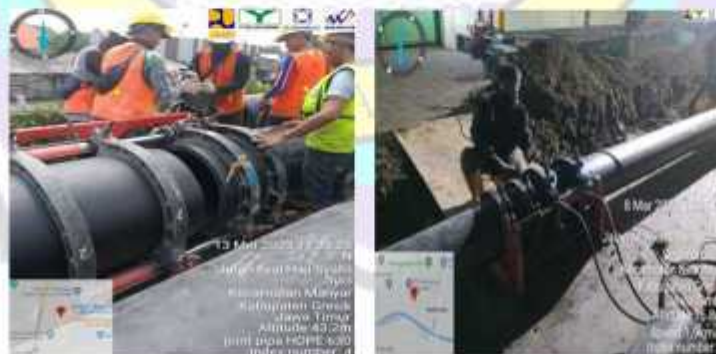
Gambar 2. 1 Metode penyambungan pipa HDPE DN
