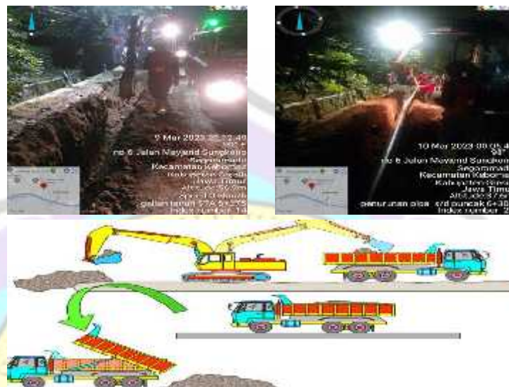
Gambar 2.2 Metode Pekerjaan Open cut
