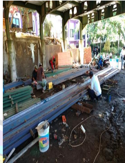
Pekerjaan Pengelasan
