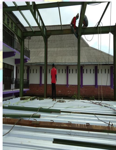
Pekerjaan Pemasangan Balok
