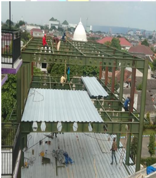
Pekerjaan Pemasangan SKUR
