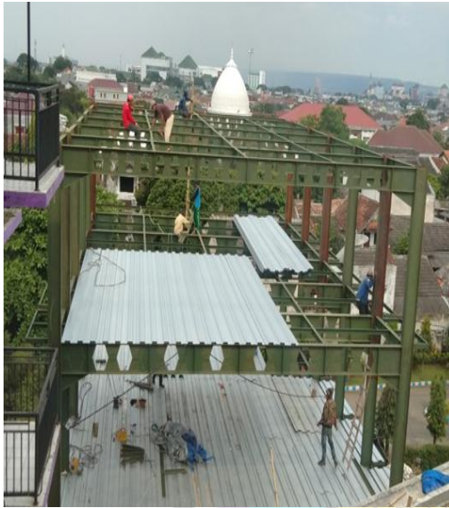
Pekerjaan Pemasangan Balok
