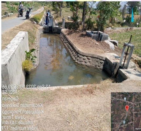
Bangunan Bagi Sadap
