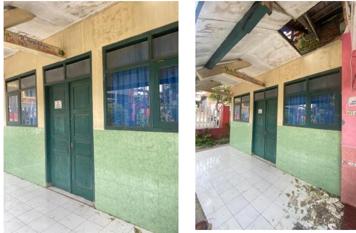
Gambar Perpustakaan di SDN 2 Mulyoagung dalam proses perbaikan
